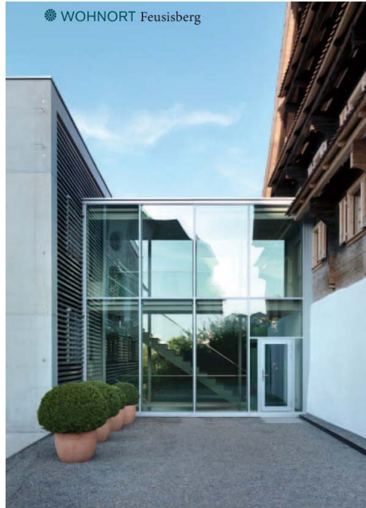
Ein filigraner, verglaster Zwischenbau verbindet das alte Schwyzerhaus mit dem neuen Betonmonolith.
