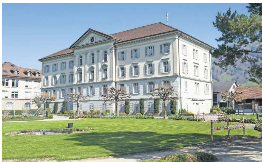
Grosse Pläne für das ehemalige Hofmatt-Altersheim: Es soll umfassend saniert und umgebaut werden.
