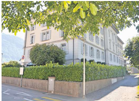
Der Seiteneingang bleibt bestehen. Neu wird aber wie ursprünglich ein Portal in der Mitte der Längsseite den Eingangsbereich erschliessen. Bild: Jürg Auf der Maur
