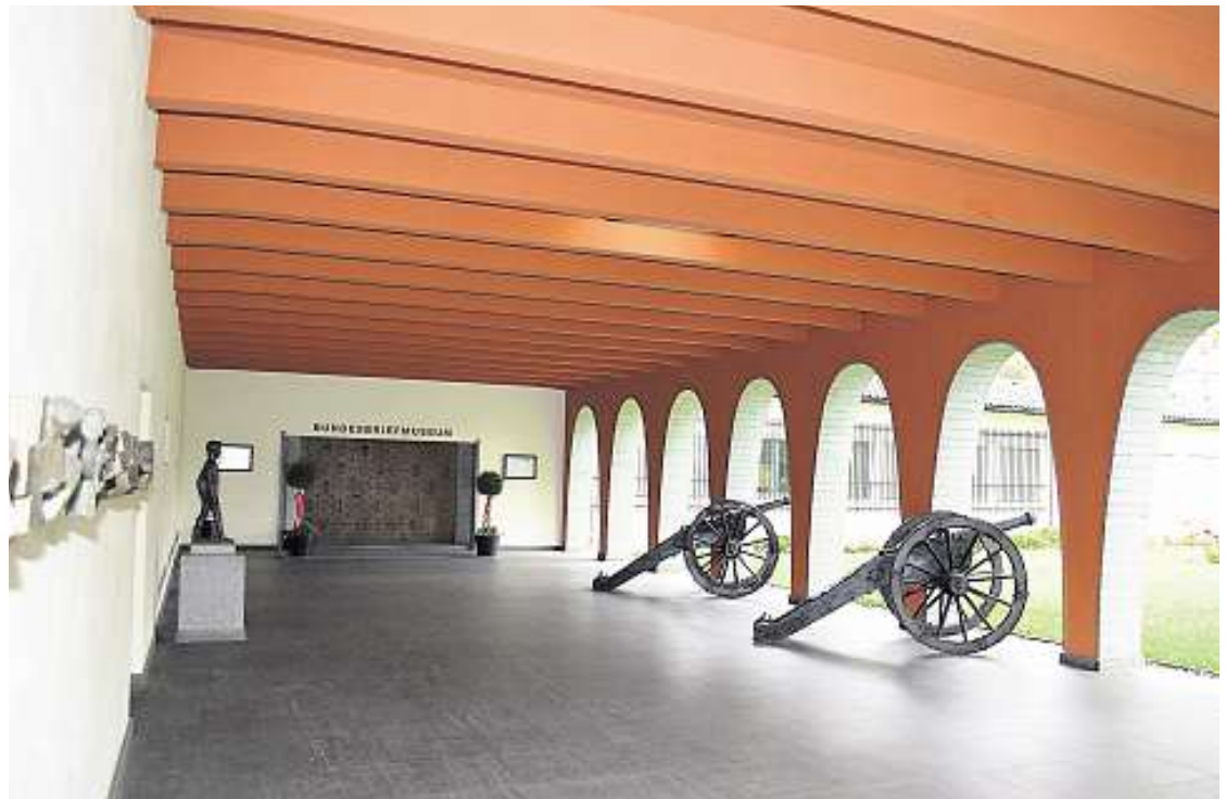
Die bisher offene Bogenhalle: Sie soll beim geplanten Umbau abgeschlossen und künftig als Eingangsbereich mit aller Infrastruktur genutzt werden.
