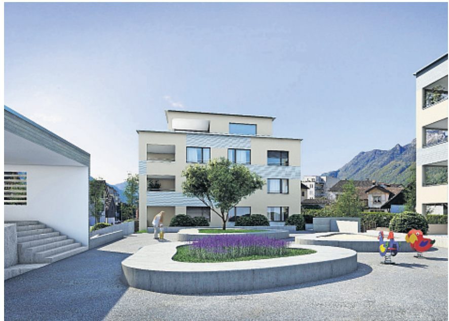
Die neue Überbauung auf dem Areal des ehemaligen Carunternehmens Bissig – hier in einer Bildanimation.
