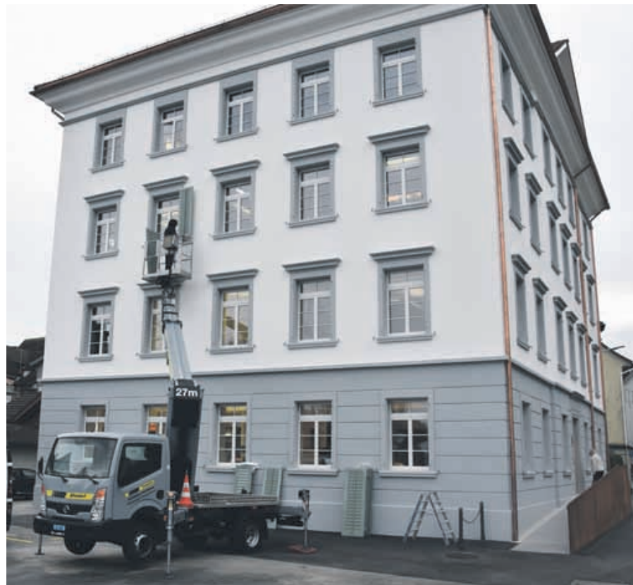
Mit den Fensterläden erhält das sanierte Lachner Gemeindehaus den letzten Schliff.
