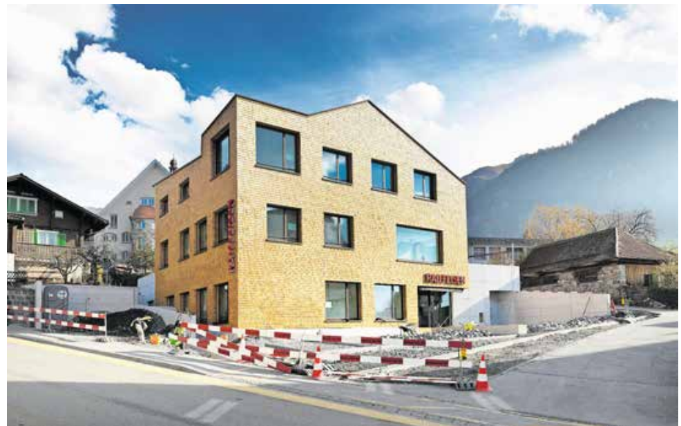
36 090 handgespaltene Schindeln aus einheimischem Holz zieren die Fassade der neuen Bankfiliale in Bürglen.
