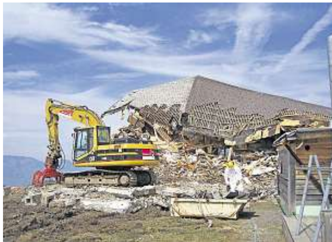
Die alte Stooshütte wird gegenwärtig abgebrochen. Es entsteht ein Hotel-Restaurant in Holzbauweise.
