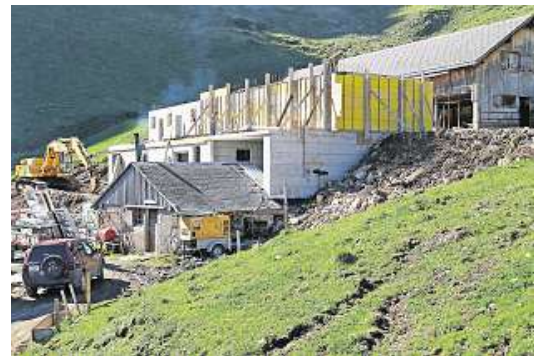
Auf die Wintersaison 2015/16 wird die neue OAK-«Stoos-Hütte» eröffnet (links). Ein neues Alpgebäude entsteht im oberen Frontal auf der UAK-Alp (rechts).
