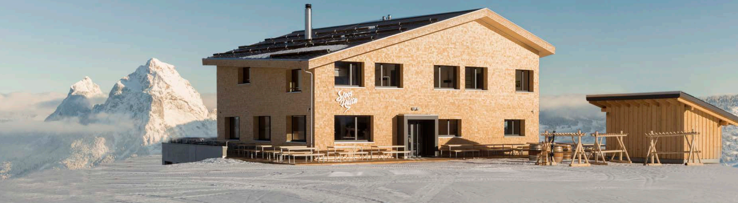
Architekt Ivan Marty aus Schwyz inszeniert das Gebäudevolumen als kompakten Holzblock.
