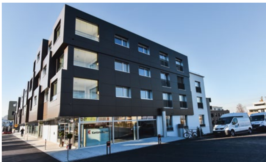
Die SZKB-Filiale Altendorf befindet sich neu an der Zürcherstrasse 60.
