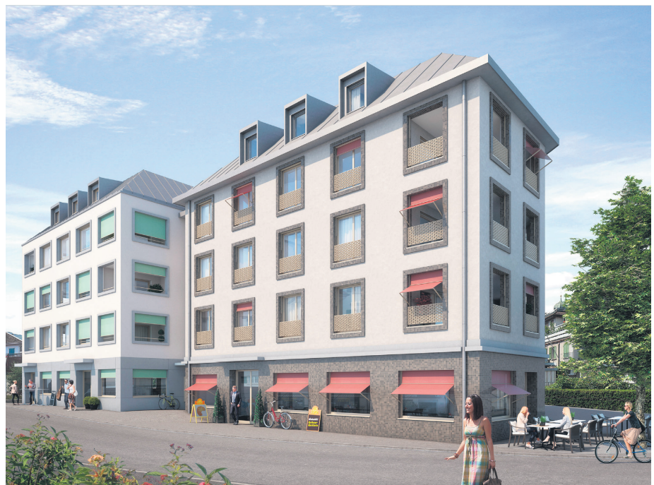
Metzgerei weicht modernem Neubau: An der Schützenstrasse in Lachen kehrt ab Frühjahr 2020 neues Leben ein.
