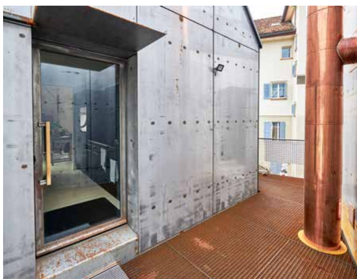
Der Eingang zu Joel Seiffers Wohnung liegt im Obergeschoss.
